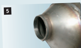
5 Wenn Öffnung am Konus gereinigt ist (alle Reste vom alten Rohr müssen entfernt sein), kann das neue Reparaturrohr problemlos eingeschoben werden.
