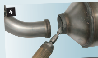
4 Schweißnaht mit dem „Schnellläufer“ auffräsen, bis sämtliche Reste vom alten Rohr entfernt werden können. Sorgfältig arbeiten!
