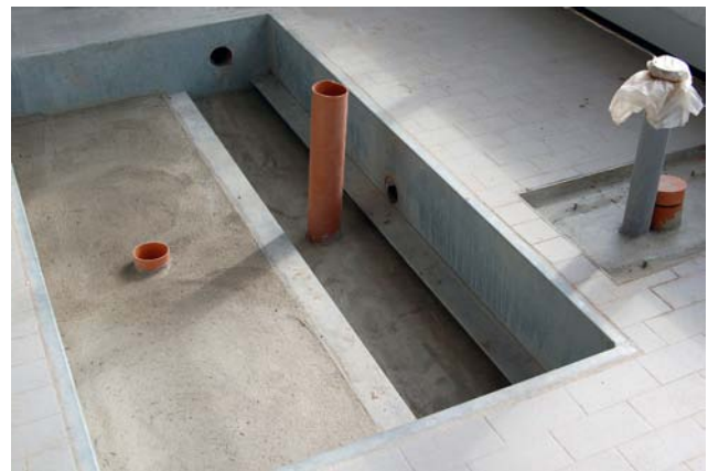
Fig. 1: Einbauwanne einbetoniert (Beispiel)
