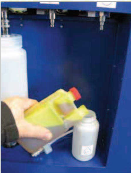
Befüllung des UV-Zusatzes
