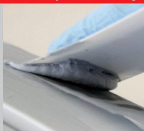
Spachtelmasse auftragen
